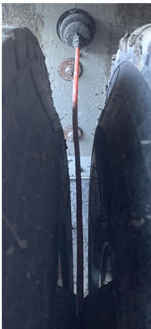
Feil montering, bøyd pisk sideveis
